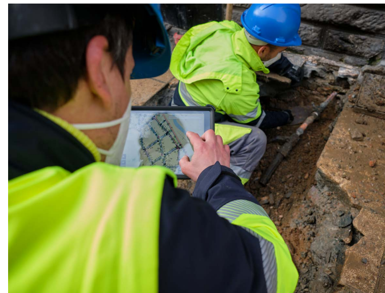
Operarios comprobando planos de redes en la aplicación GIS
